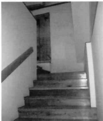
stubište-ulaz u potkrovlje
