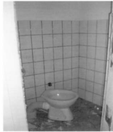
wc-montaža nove školjke
